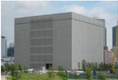
某データセンター
